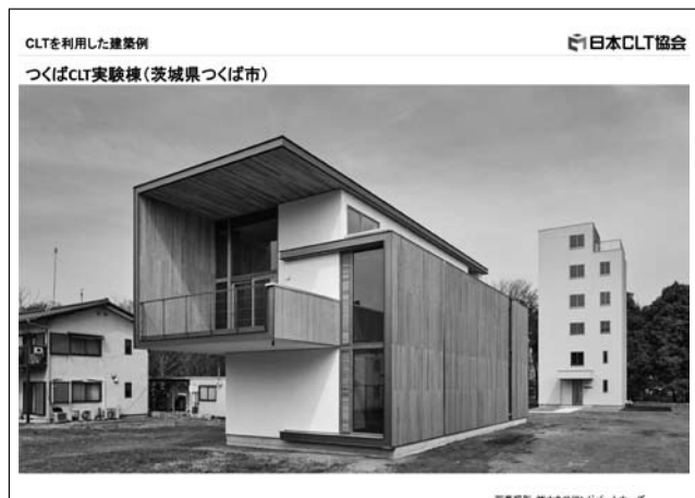
図1 つくば CLT 実験棟
