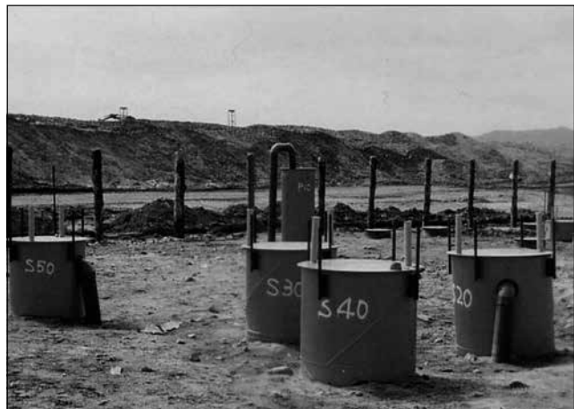
図6 処理杭の全景
