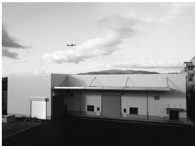
写真-1 耐火防火試験室(池田)試験体製作棟外観
