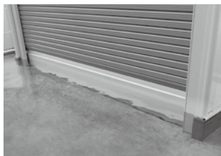
止水性能試験の様子
