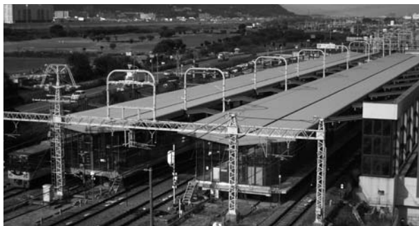
京阪電気鉄道(株)樟葉駅舎工事
