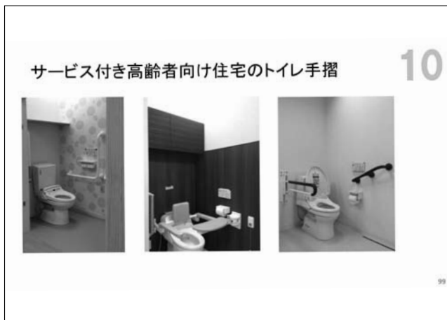
図6 サービス付き高齢者向け住宅のトイレ手摺
