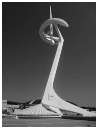
▲エスタディ・デ・モンジュイック (サンティアゴ・カラトラヴァ作) バルセロナオリンピックのメイン会場となったモンジュイックの丘につくられたシンボルタワー。二股に分かれた足と付け根の三点により支えられている。
