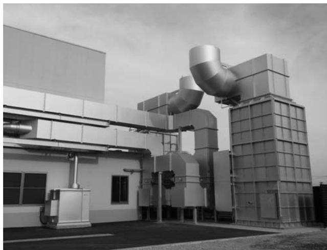
写真-4 排煙処理装置(2基)
