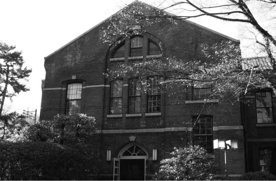
最初の図書館となった有終館
