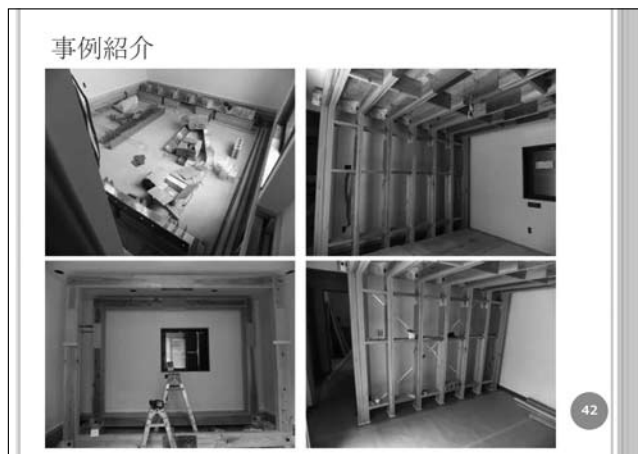
図6 住之江区にある耐震化した事例（内観）
