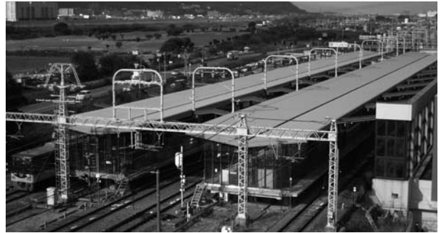
京阪電気鉄道(株)樟葉駅舎工事
