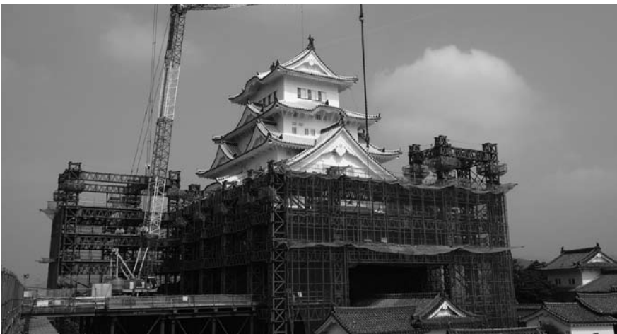
素屋根の解体
