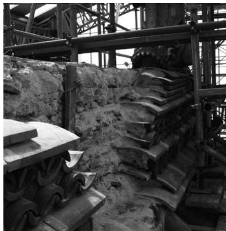
五重大棟の棟積解体調査
