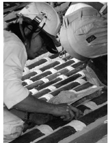
屋根の目地漆喰塗り作業中
