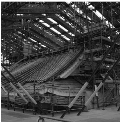
五重屋根の瓦を撤去中
