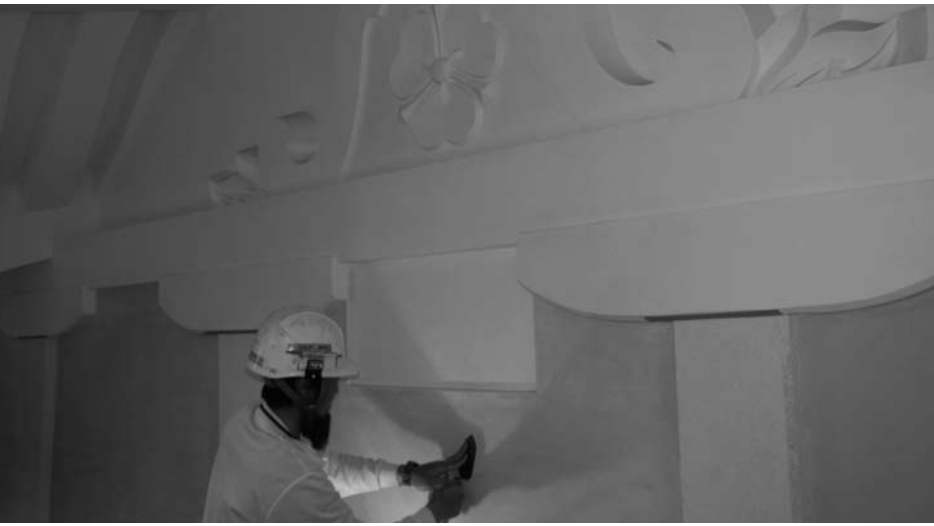
壁の漆喰塗りの様子
