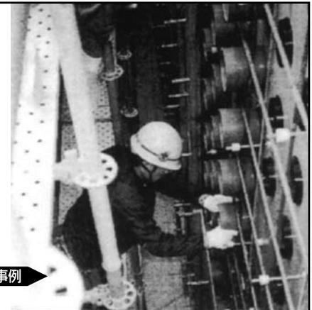
型枠へ釘イッパツ → スリーブ材はあとで装着。
