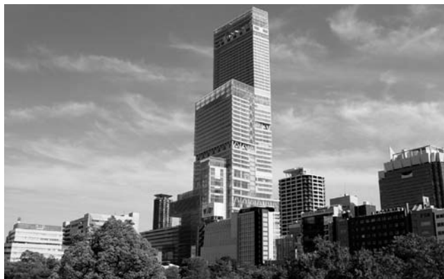
図1 あべのハルカス外観
