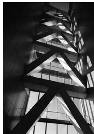
図5 耐震ブレース
