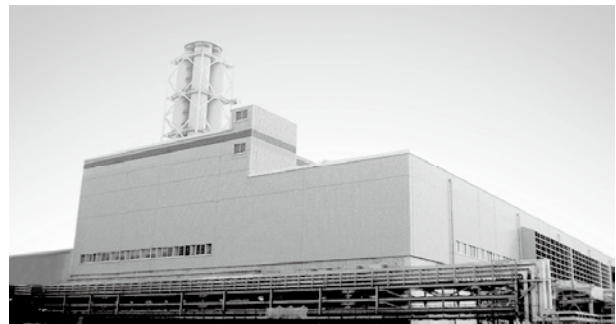
中部電力(株)上越火力発電所本館工事
