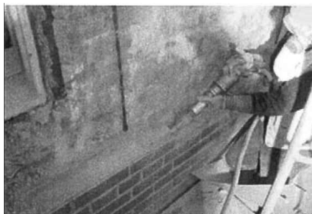
図4 レンガ取り外し工事の様子
