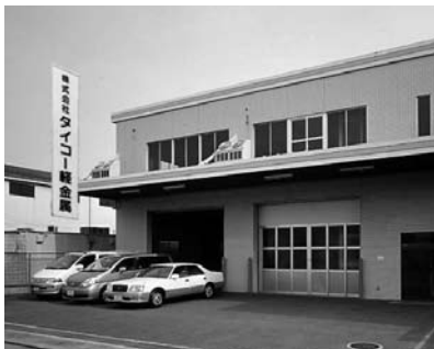
東大阪オフィス・工場外観
