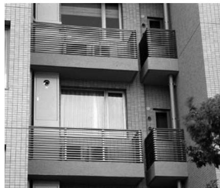
ベランダ手すりのルーバー
