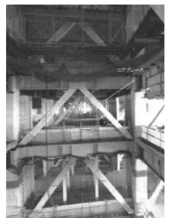
鉄骨ブレースの一つ、コアブレース
