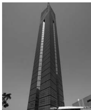
施工実績：福岡タワー
