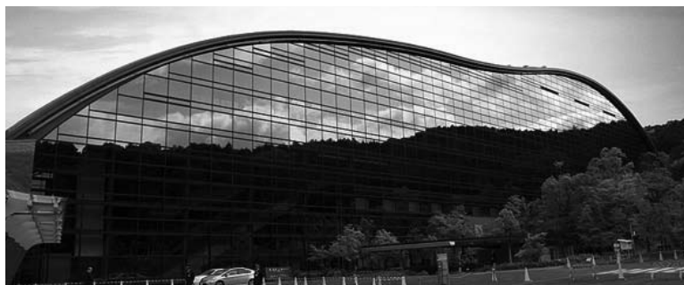
施工実績：九州国立博物館
