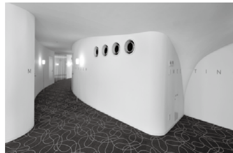
FPエフジーボード耐火60のイメージ図（上）と曲面施工例（下）
