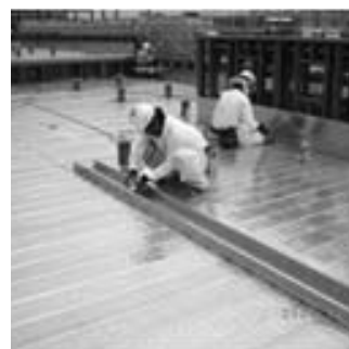
防水雨仕舞材取付工事の様子
