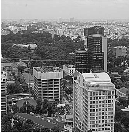
新たな建物が続々と建設中(ホーチミン市1区)
