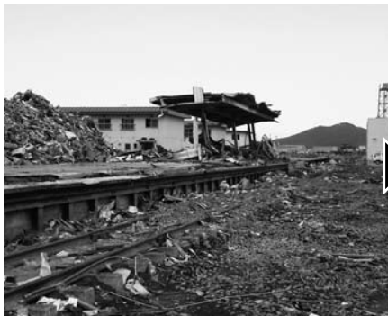
写真11 JR南気仙沼駅プラットホーム。ホームの上に架かった屋根までもボロボロになっている。(2011年7月11日)
