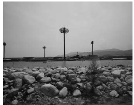
写真36 海岸近くにある市営球場は、照明塔とスタンドの一部を残して水没した。地面が沈下しているため、水位が元に戻ることはない。(2012年7月29日)
