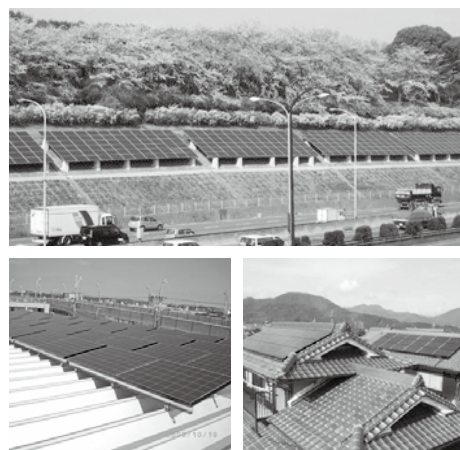
当社施工例（上：万博公園、下左：工場、下右：一般住宅）
