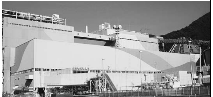
TOF御採用例：関西電力(株)舞鶴発電所本館外壁工事
