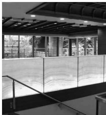
ほのかに光るオニキス(シマメノウ)のTHパネル(右)と、その施工例(左)
