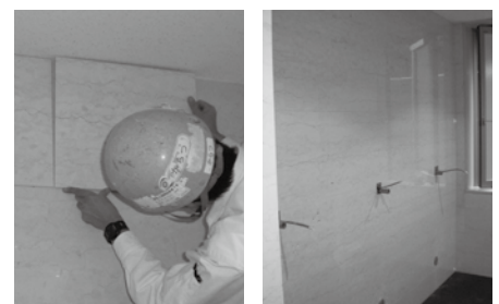
施工中のUTパネル (左) と仕上がり状況 (右)
