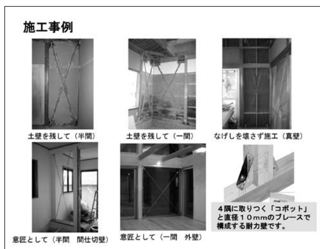
図4 「コボット」による施工事例
