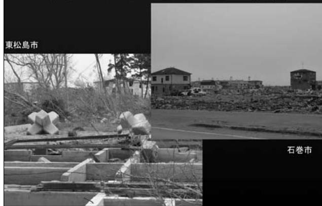
図5 津波による木造住宅の被害
