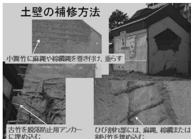
写真-26 土壁の補修方法
