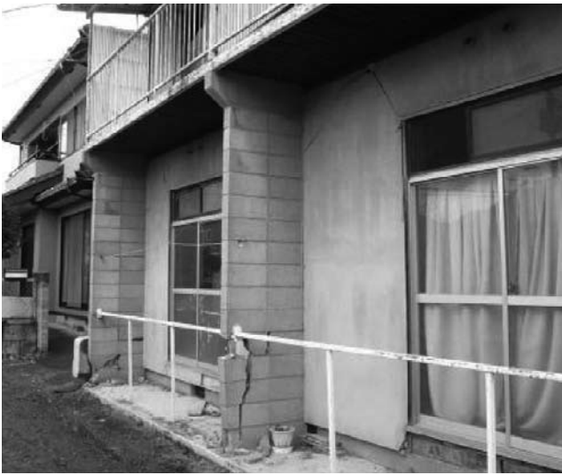
写真-29 ブロックによる耐震補強例
