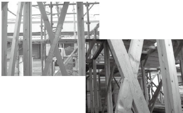
写真-6 金物で適切に補強された筋交い
