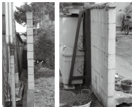
写真-28 無補強(左)と補強されたブロック塀(右)
