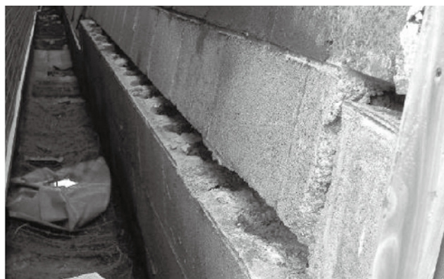
写真-7 無筋のコンクリートブロック造基礎
