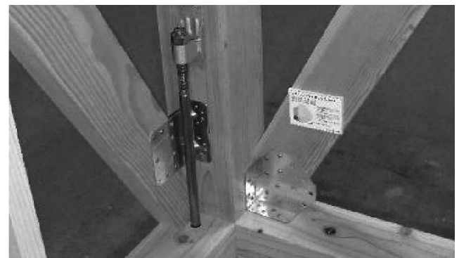
写真-3 現行建築基準法に適合した金物の使い方の例
