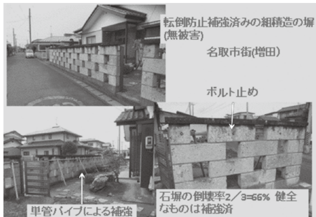
写真-27 鋼管で補強された石塀
