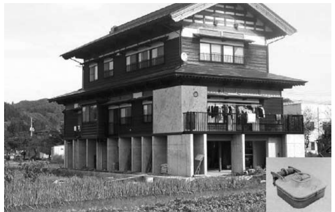
写真-31 RCシェルターを有する高床式基礎住宅の例
