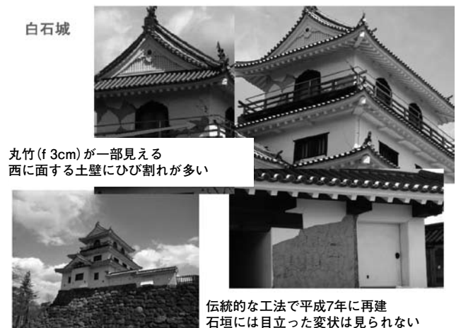
写真-16 土壁の被害例
