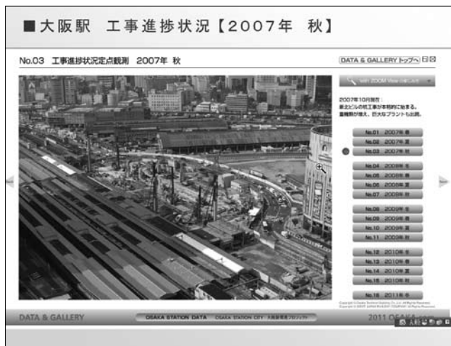
図1 2007年秋の工事進捗状況
