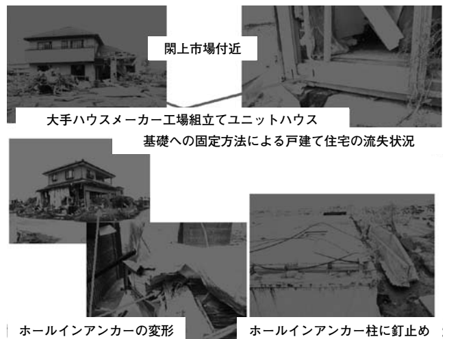
写真-25 戸建て住宅の津波による被害例
