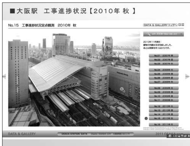
図2 2010年秋の工事進捗状況
