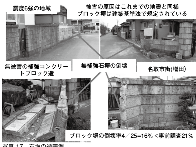
写真-17 石塀の被害例
