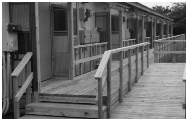
弾力的な判断で造られた木造仮設(同町)
