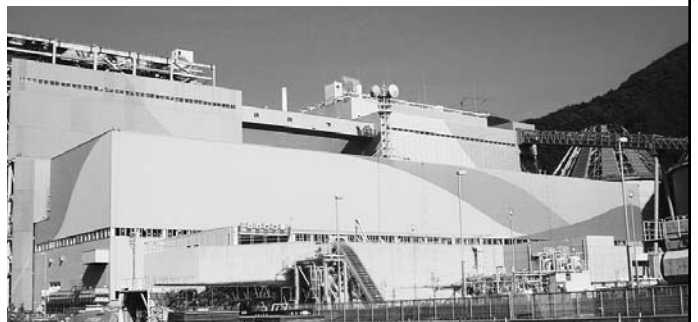
TOF御採用例：関西電力(株)舞鶴発電所本館外壁工事
