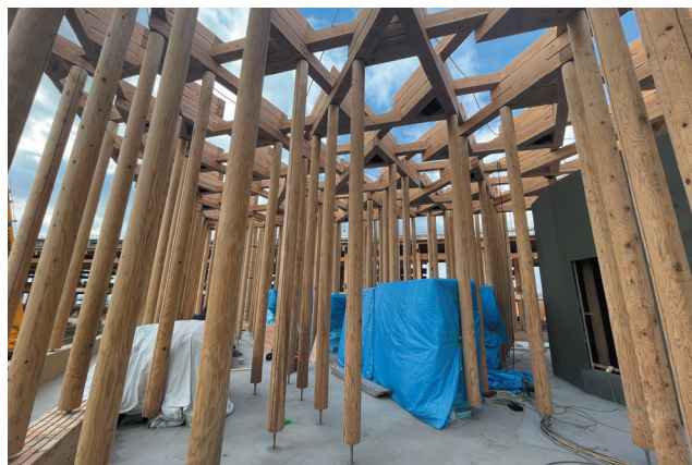
図6 パーゴラ建設中(一部拡大)
