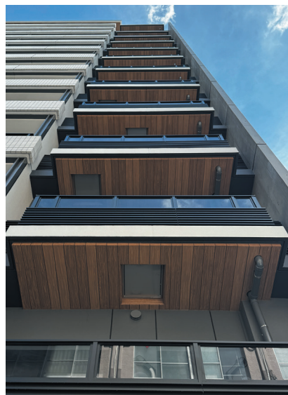
施工事例 仕上げ工法：G-PF システム特殊描画（木目風）
