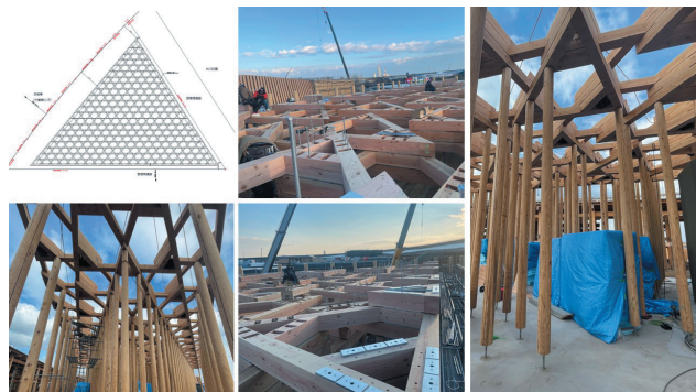
図5 ウズベキスタンパビリオン、パーゴラ建設中の様子
