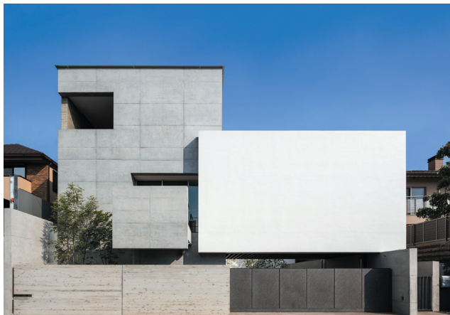
施工事例 仕上げ工法：N-RC システム・特注ホワイト色+ピュアコート (撮影：松村芳治)
