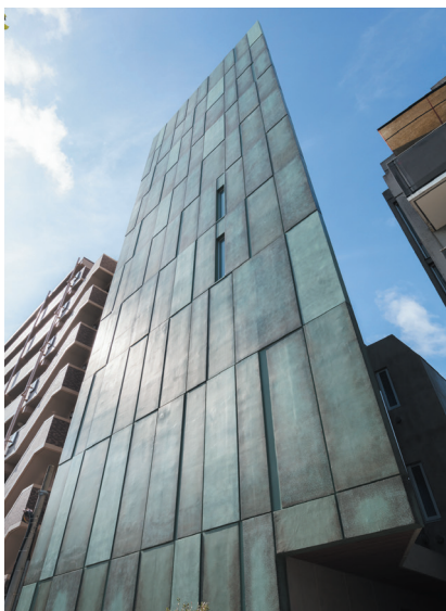
施工事例 仕上げ工法：G-PF システム特殊描画（緑青風）（撮影：中山保寛）
