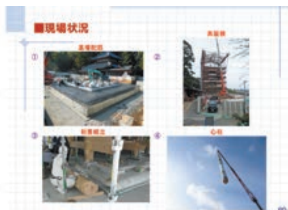
図5 基礎の構築後、初重から組み上げていく
