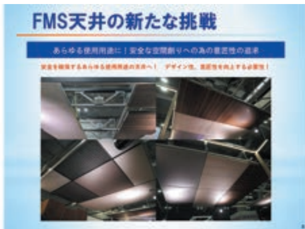
意匠性も妥協しない告示耐震天井基準をクリアした超軽量天井が「FMS 天井」
