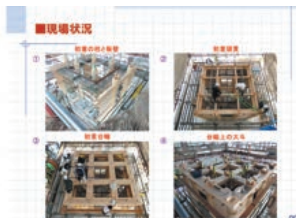
図6 初重の柱、板壁などの設置
