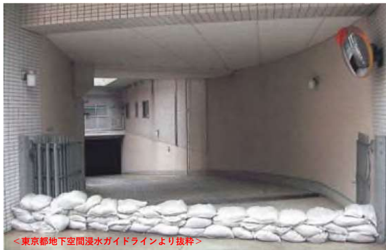
土のうを設置
