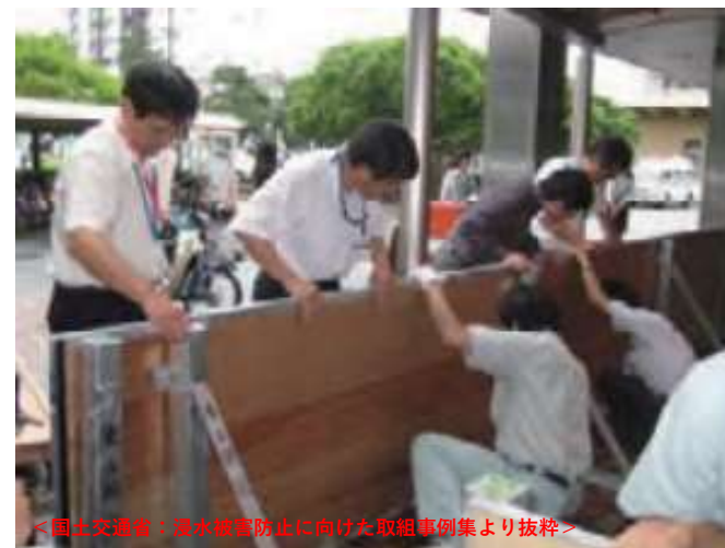
木の止水板を設置
