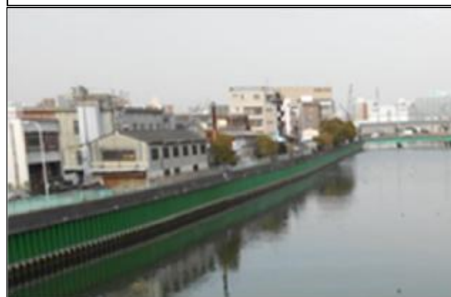
防潮堤の耐震補強（対策前）
