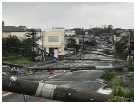
電柱倒壊（平成30年台風21号）
