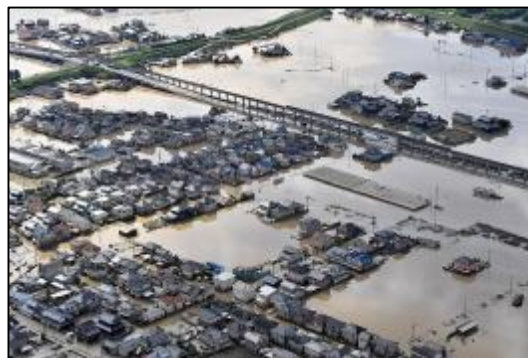
浸水被害（平成30年7月豪雨）
