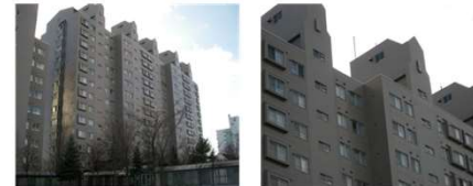
札幌市北区あいの里 某マンション
