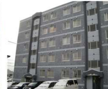
札幌市清田区北野 某マンション
