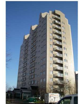
札幌市北区あいの里 某マンション
