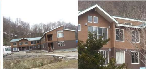
平成26年4月完成 老健施設 (洞爺湖)
