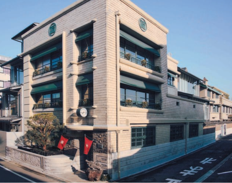
一番手前が入口となる旧事務所棟で、奥に棟が並ぶ
