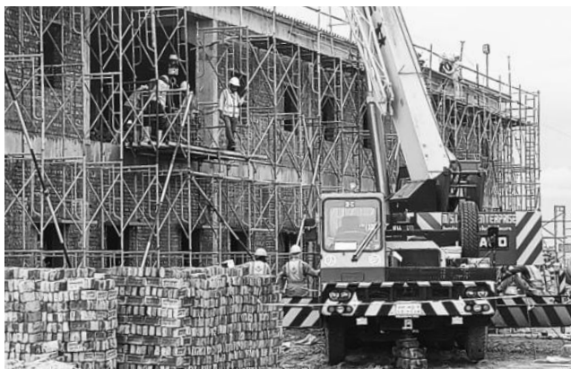
現地の業務提携建設会社の建設現場（バングラデシュ労働者用宿舎）
