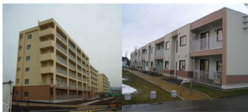
平成18年度 美瑛市営住宅 平成24年度 東川町 公営住宅
