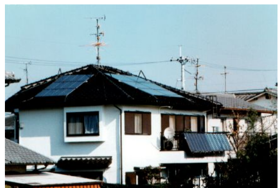
図20 日本初の個人住宅用逆潮流あり太陽光発電システム
