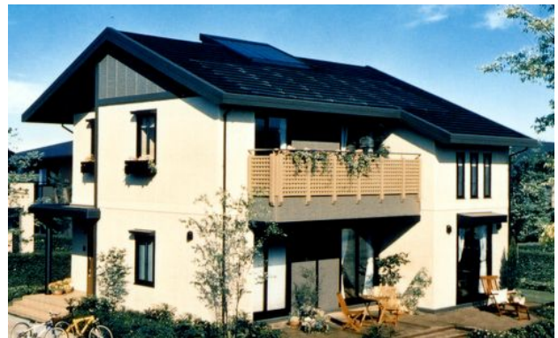
図25 建材一体型太陽電池設置例
